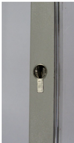
Rys. 4.5. Sposób montażu wkładki do zamka w obudowie
